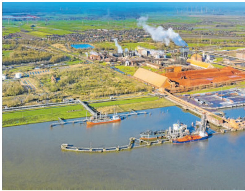
Nord-Ausbau und LNG-Terminal: der Stader Seehafen.
